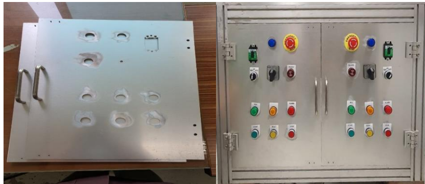
ภาพที่ 3-5 ติดตั้งอุปกรณ์ที่แผงวงจรควบคุม
