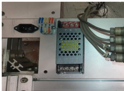
ภาพที่ 3-7 ติดตั้งเต้ารับและเทอร์มินอลและ Power Supply
